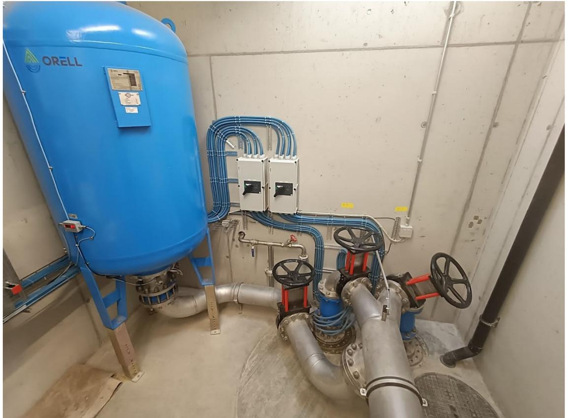
**Abbildung 24: Vergleichbarer Druckschlagdämpfer**
