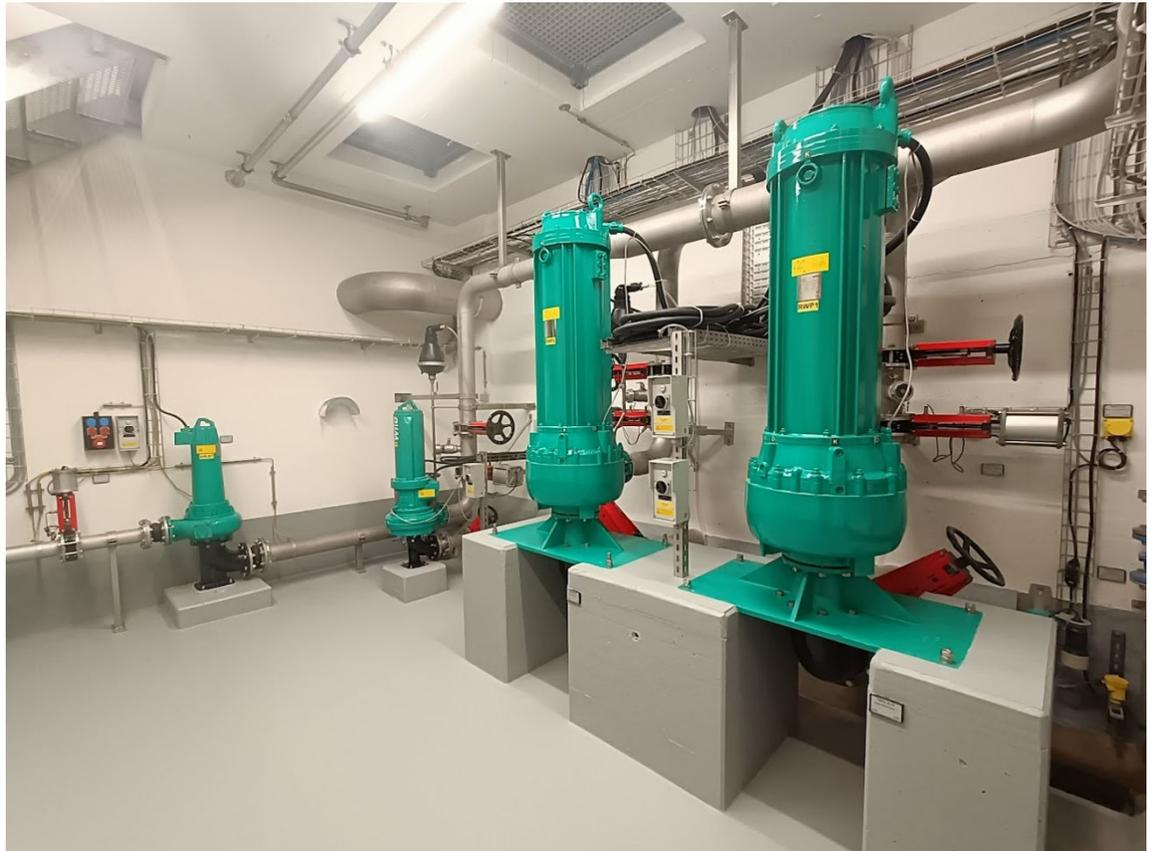
**Abbildung 23: Vergleichbare trocken aufgestellte Zentrifugalpumpen.**
